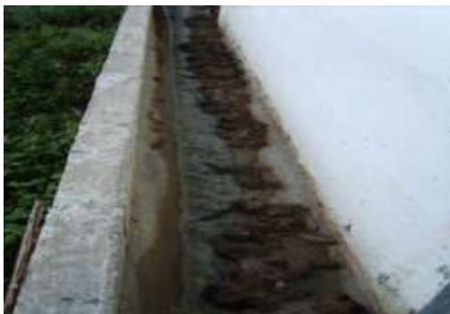
Foto 2: Acumulación de Materia Fecal en los canales de Recolección
